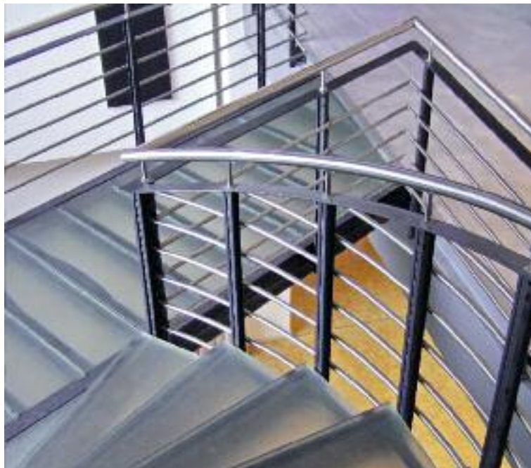
Rysunek 5: W normalnie napowietrzonym i ogrzewanym środowisku wewnątrz nie występują elektrolity a połączenie stali nierdzewnej z innymi materiałami metalowymi takimi jak pomalowana stal węglowa zwykle nie pociąga za sobą korozji galwanicznej.
