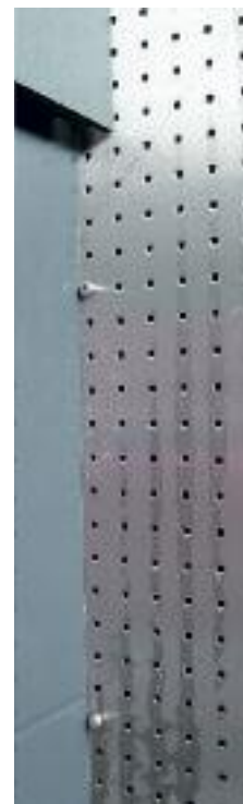
Rysunek 11: W celu przeciwdziałania korozji galwanicznej do łączenia paneli ze stali nierdzewnej należy stosować elementy łączne jedynie ze stali nierdzewnej.
